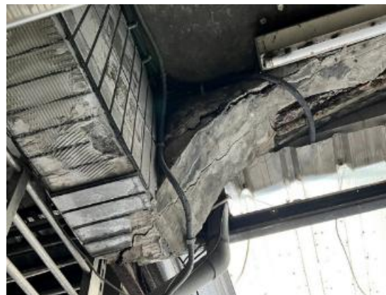
圖 10 建物現況照片 (3)
