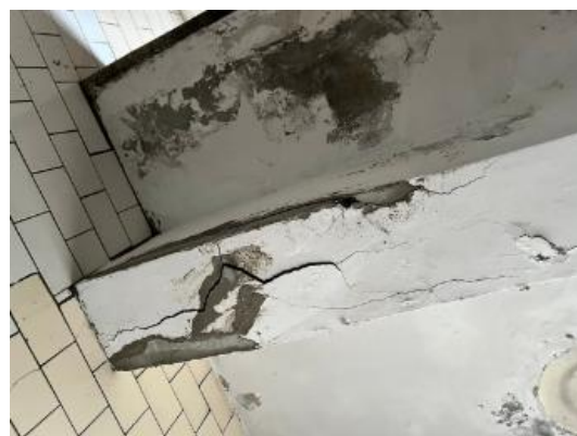
圖 11 建物現況照片 (4)
