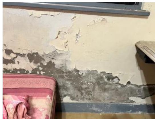
圖 9 建物現況照片 (2)
