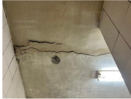
圖 13 建物現況照片 (6)
