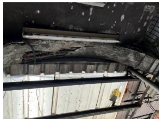
圖 8 建物現況照片 (1)
