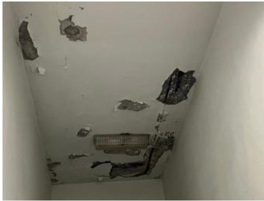
圖 12 建物現況照片 (5)
