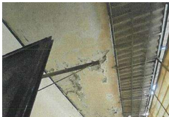
圖12 建物現況照片(5)
