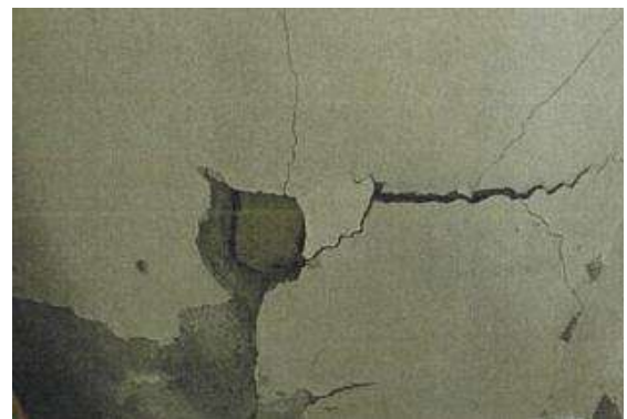
圖13 建物現況照片(6)
